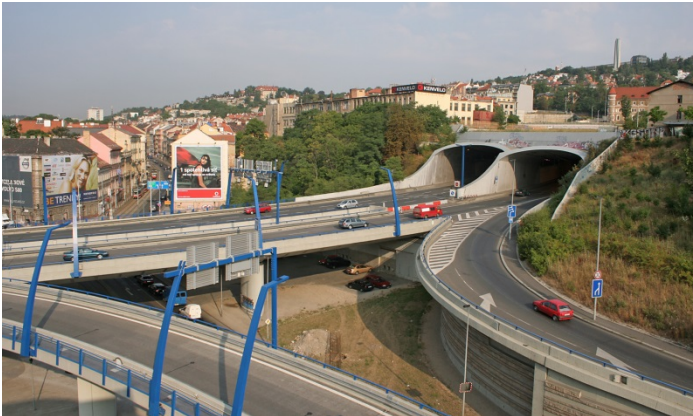
Figure 6 – têtes Sud du tunnel de Strahov et vue du pont donnant accès au tunnel de Mrázovka
