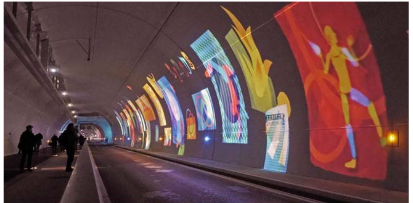
Figure 9 – animation des piédroits du tunnel
