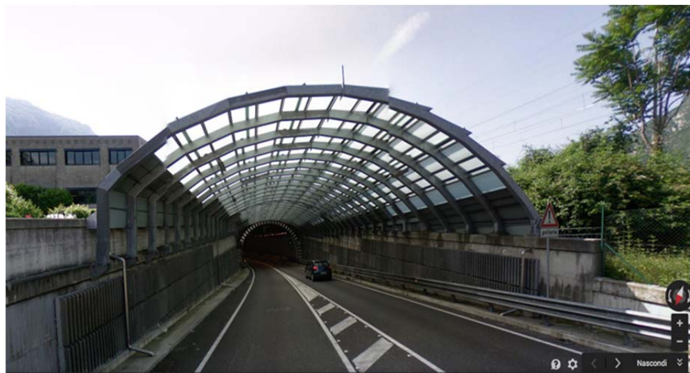
Figure 2: tête de tunnel de Lecco (ci-dessous l'hyperlien pour la visite de l'intérieur du tunnel)
