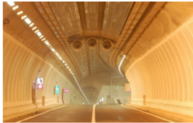
Figure 7: vues de détail de la signalisation (a) - installation de ventilation au droit du diffuseur souterrain (b), - installations de ventilation et atténuateurs acoustiques (c).
