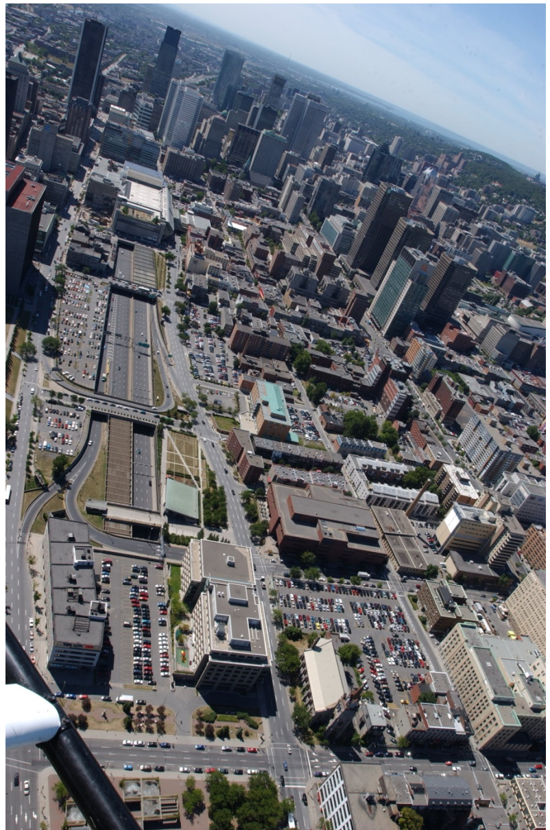
Figure 3 – Secteur en tranchée ouverte entre les tunnels Viger (en bas) et Ville-Marie (en haut)
