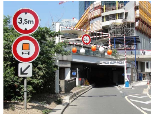
Figure 4 : entrance portal - Voie des Bâtisseurs
