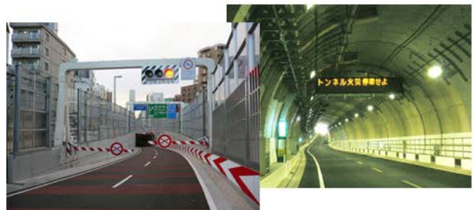
Figure 4 – principaux équipements d'exploitation et de sécurité du tunnel de Yamate
