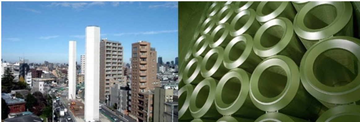
Figure 6 – tours de ventilation et atténuateur de bruit
