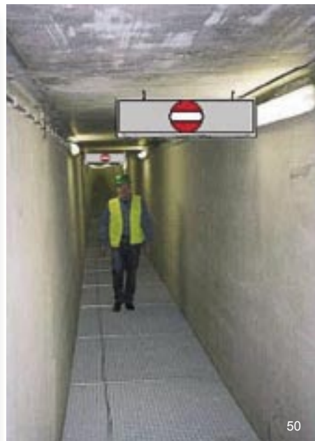
Figure 49 : panneau monté au plafond des galeries de sécurité situées entre les tubes pour indiquer la direction et la distance à parcourir jusqu'à l'air libre
