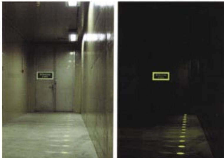
Figure 46 : exemple de galerie de communication avec et sans éclairage. Notez les points photo-luminescents et auto-adhésifs sur le sol guidant vers la porte de l'autre tube.
