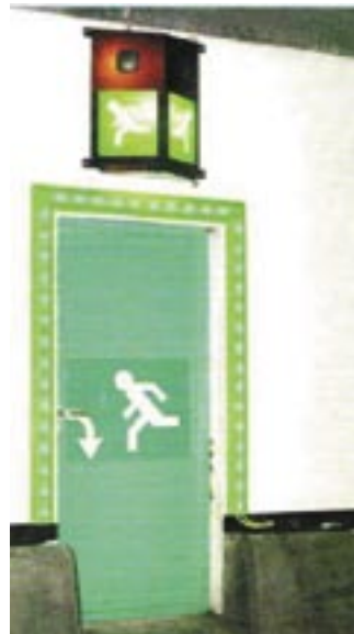
Figure 44 : exemple d'issue de secours encadrée de diodes électroluminescentes (allumées uniquement en cas d'urgence), avec pictogramme de l'issue de secours allumé en permanence et balise sonore au-dessus de la sortie. (Pays Bas)
