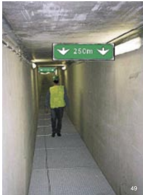
Figure 49 : panneau monté au plafond des galeries de sécurité situées entre les tubes pour indiquer la direction et la distance à parcourir jusqu'à l'air libre
